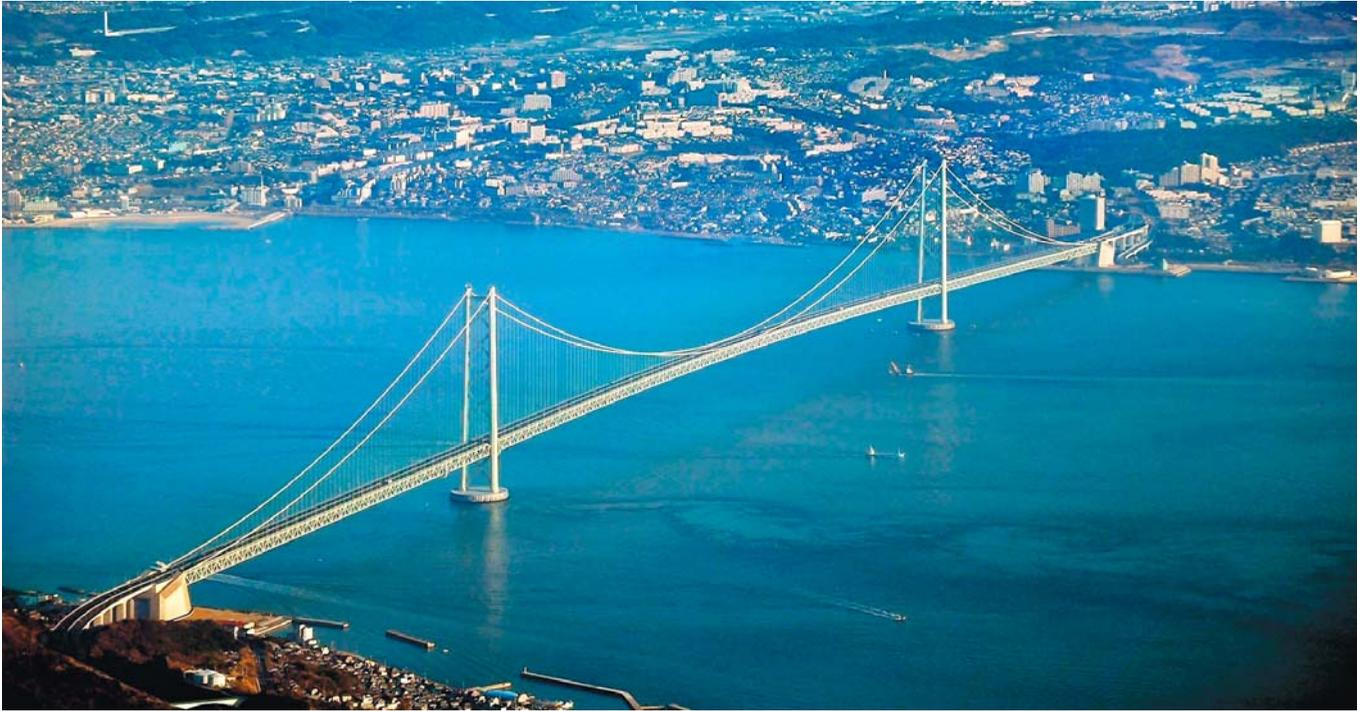
**TAHAN GEMPA:** Jembatan Akashi Kaikyo di Jepang merupakan jembatan bersuspensi terpanjang di dunia. Selesai dibangun 1998 dengan panjang 1.99 km. Jembatan yang menghubungkan Kobe dengan Awaji Island ini juga dilengkapi rel kereta api. Jembatan ini dibangun tahan gempa dimana pada 1995 jembatan sanggup bertahan terhadap gempa berskala 7.2 richter
