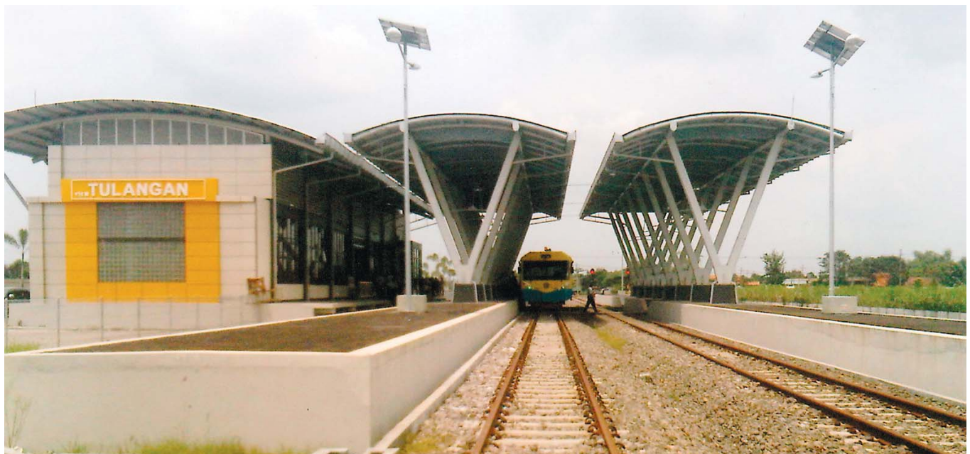
UJICoba LINTAS: Stasiun Tarik - Tulangan - Sidoarjo, sepanjang 24 km diujicoba operasional sebagai antisipasi dampak lumpur Lapindo. Stasiun Tulangan yang menggunakan listrik tenaga surya produk PT.LEN.
