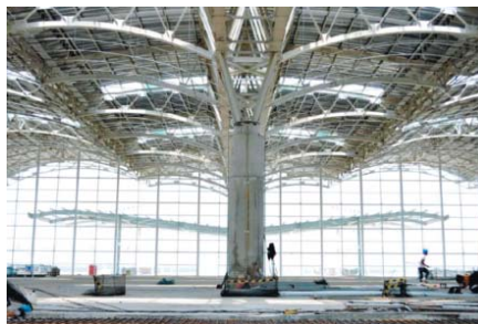
Konstruksi menyerupai pohon sawit
