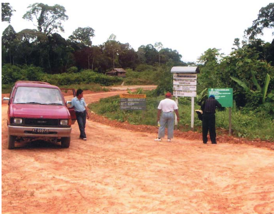
PROYEK: Jalan Trans Kaltim-Desa Bebakung. Badan jalan sudah ada sebelum ditender
